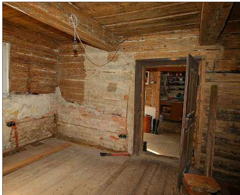
Viele Räume des Gerberhauses werden gerade saniert. Unter dem alten Putz kommen die mächtigen Holzbalken zum Vorschein.
